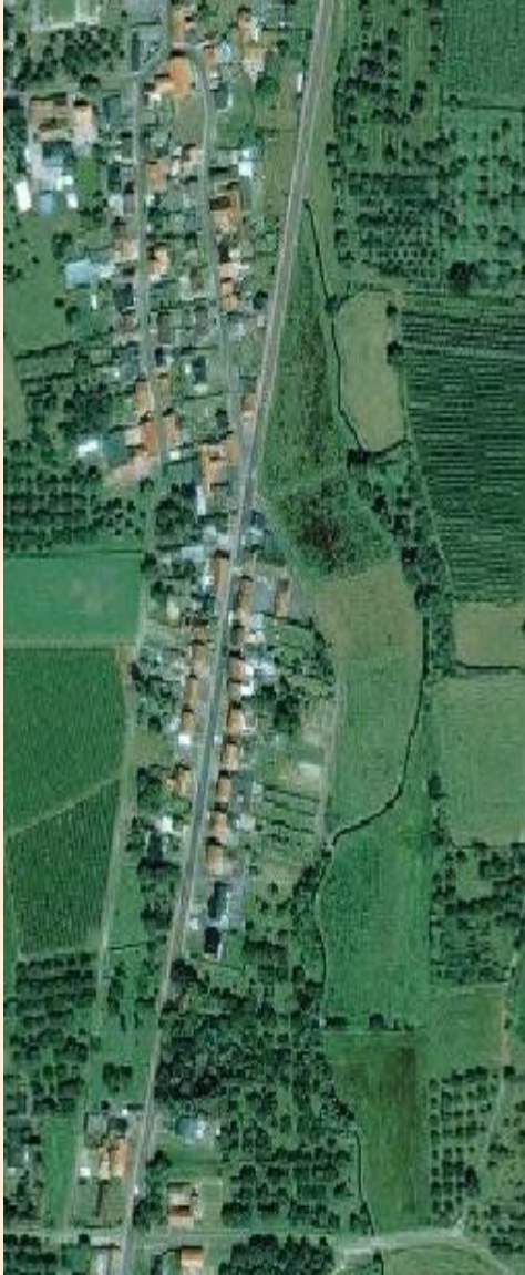
Toestand voor de aanleg
