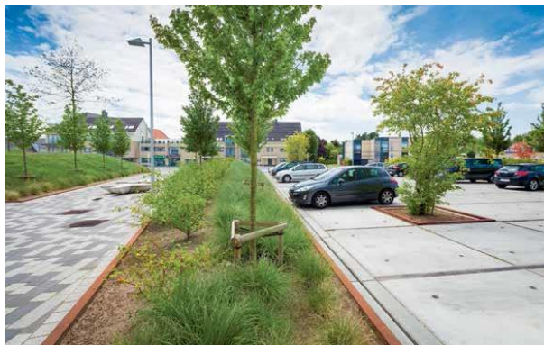
Figuur 13 Voorbeeld van een parking in de dorpskern van Wachtebeke. De afstroom van de verhard oppervlakten wordt opgevangen in groene voorzieningen.
