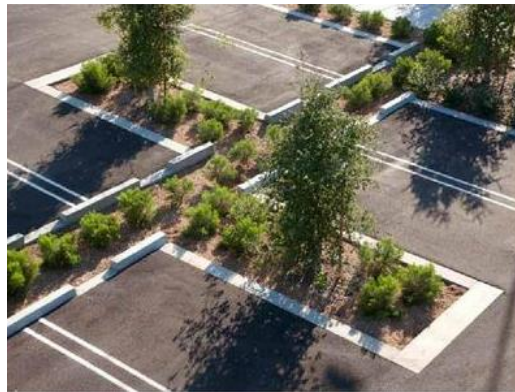
Figuur 23 Voorbeelden van waterdoorlatende verharding.
