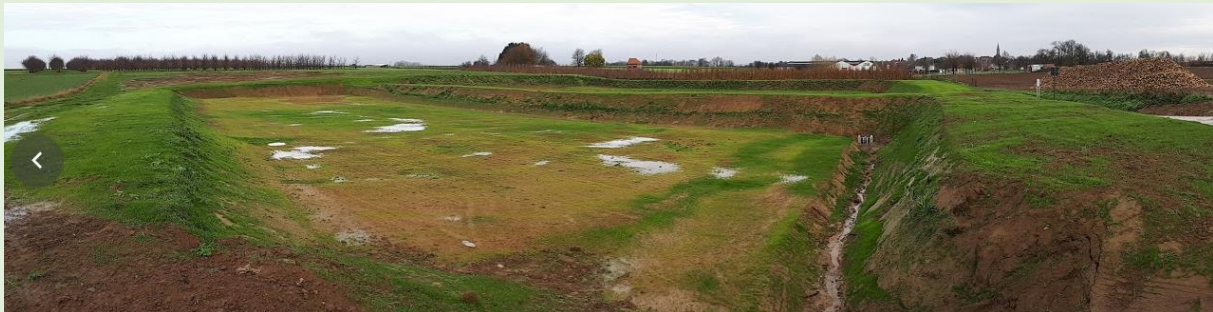
Fig. 4: Foto van de aangelegde erosiebuffer (werken nog niet afgerond)
